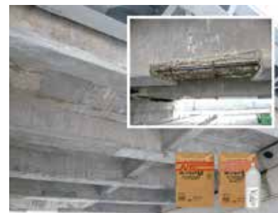
NETIS登録「NCショット」で補修した橋梁
