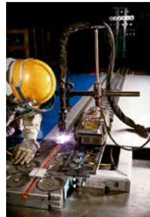
「オクトロック」を使用した プラズマ溶接作業
